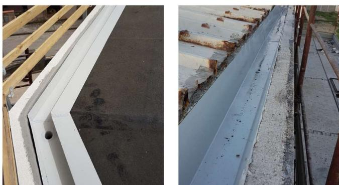
Grondaie su misura per rivestire in modo definitivo di grondaie e canali interni in muratura. Disponibili in rame e alluminio in diverse colorazioni e sviluppi.
